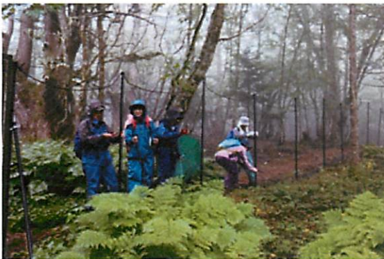
8/27 雨の中での鹿除けネット柵点検作業
